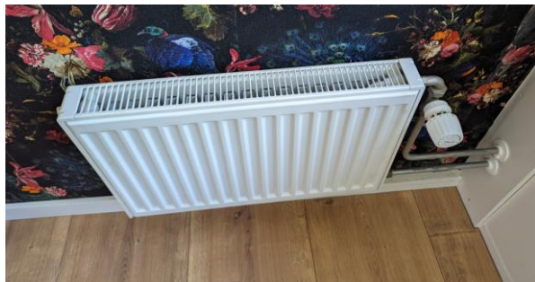
Foto 2: Paneelradiatoren
