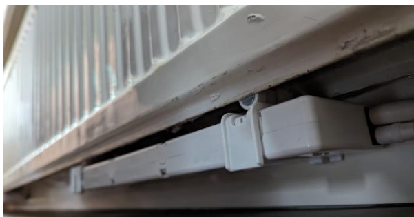
Foto 2: Dubbel paneel radiator, type 22 radiatorventilatoren
