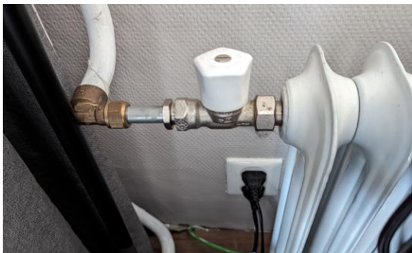
Foto 2: Enkele kolomradiatoren nog
