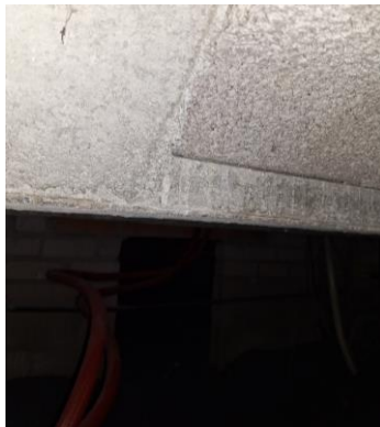
Foto 3a en b: Kruipruimte met bodemisolatie
